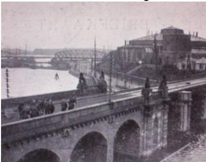
foto 1903 viaduct korte prinsengracht
